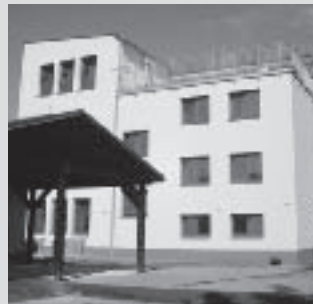
Toto je pohled na budovu dětského domova ze zabradly.
