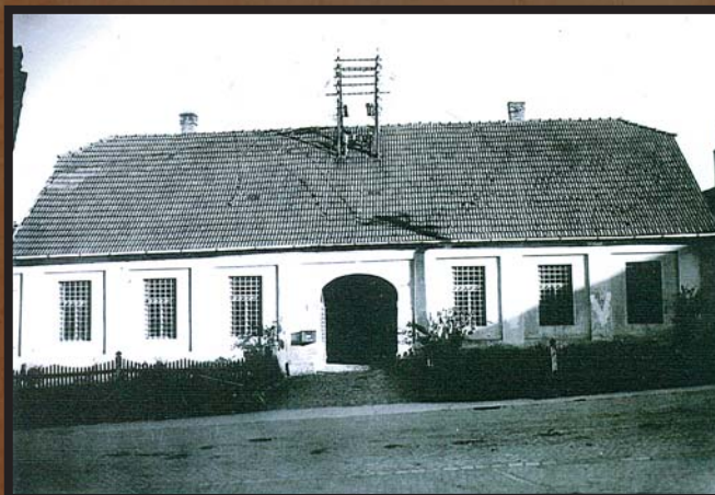
Čelní pohled na poštu č.p. 352.
