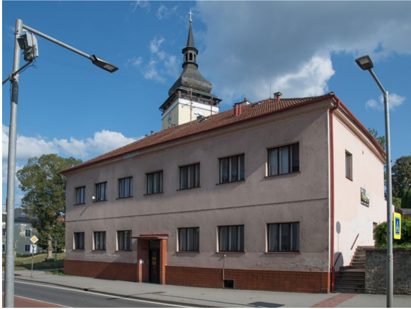
BYTOVÝ DŮM Č.P.367 rekonstrukce (zahájena v době vydání publikace). 2018
