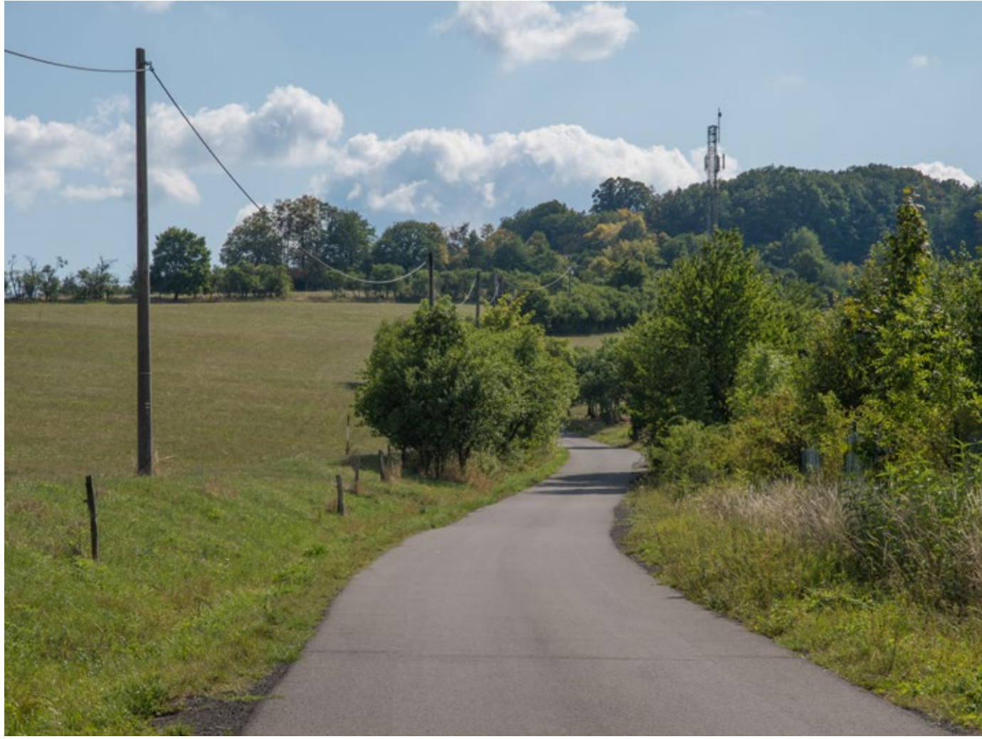
CESTA NA JANOVU HORU dokončení rekonstrukce komunikace. 2015
