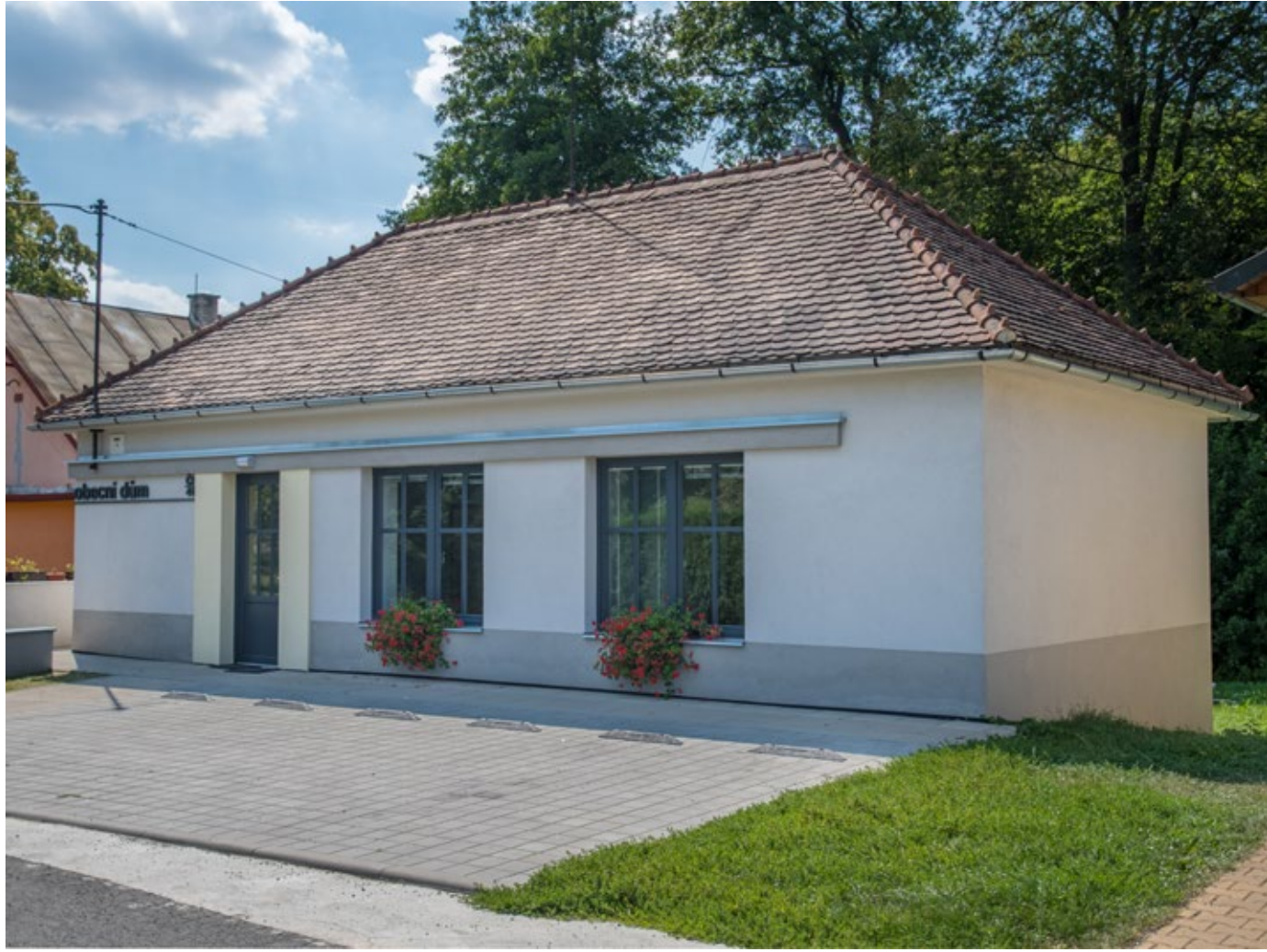
OBECNÍ DŮM CHRÁSTĚŠOV dokončení. 2016
