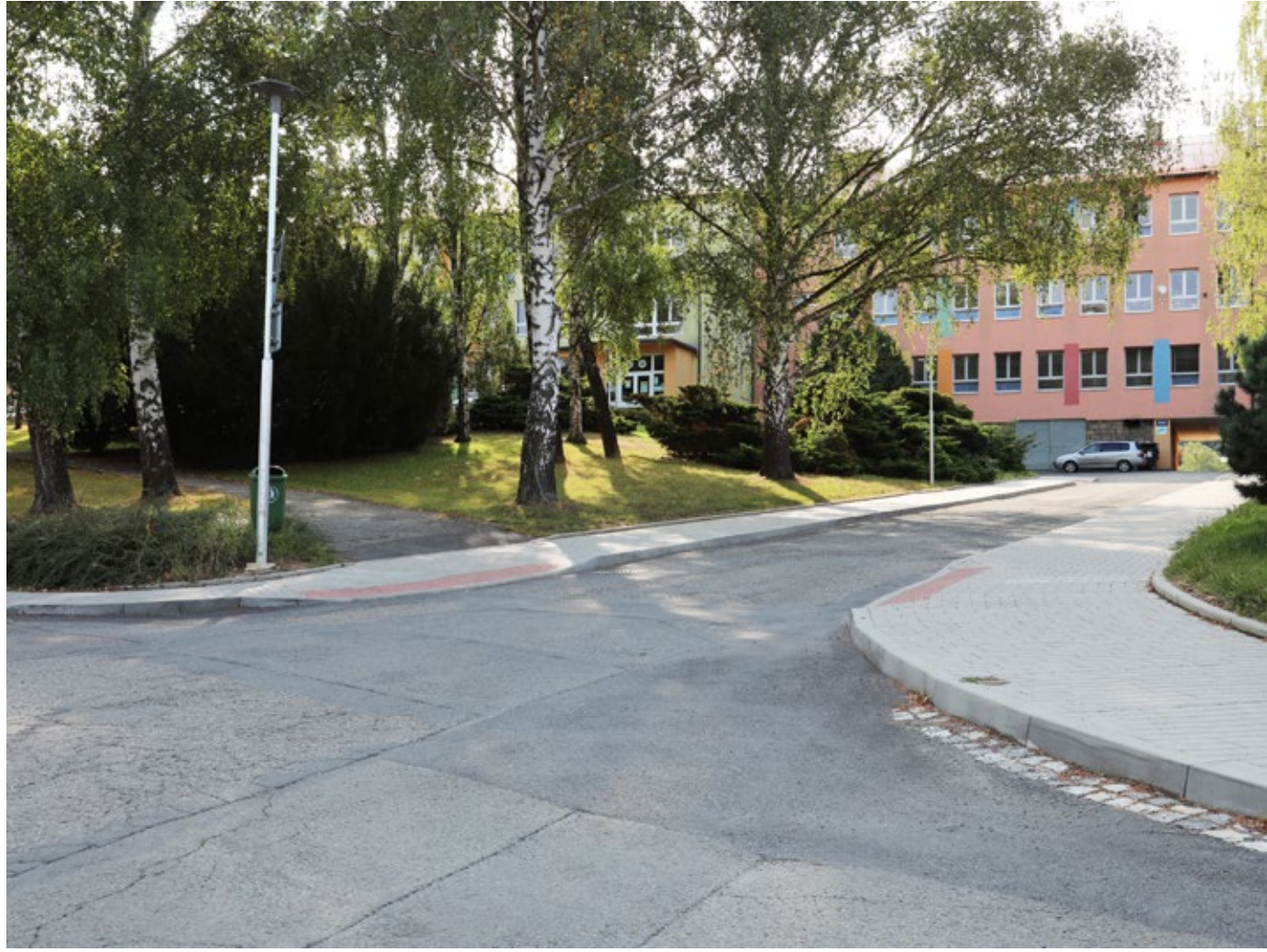
ULICE ŠKOLNÍ rekonstrukce chodníku, 2017
