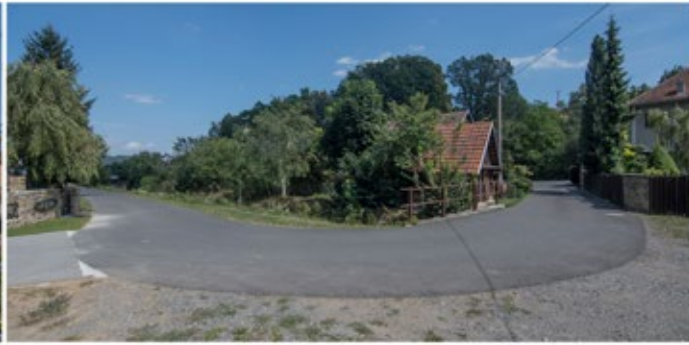
PŘIČNÁ, ZAHRADNÍ A LÁZEŇSKÁ rekonstrukce místních komunikací. 2017-2018
