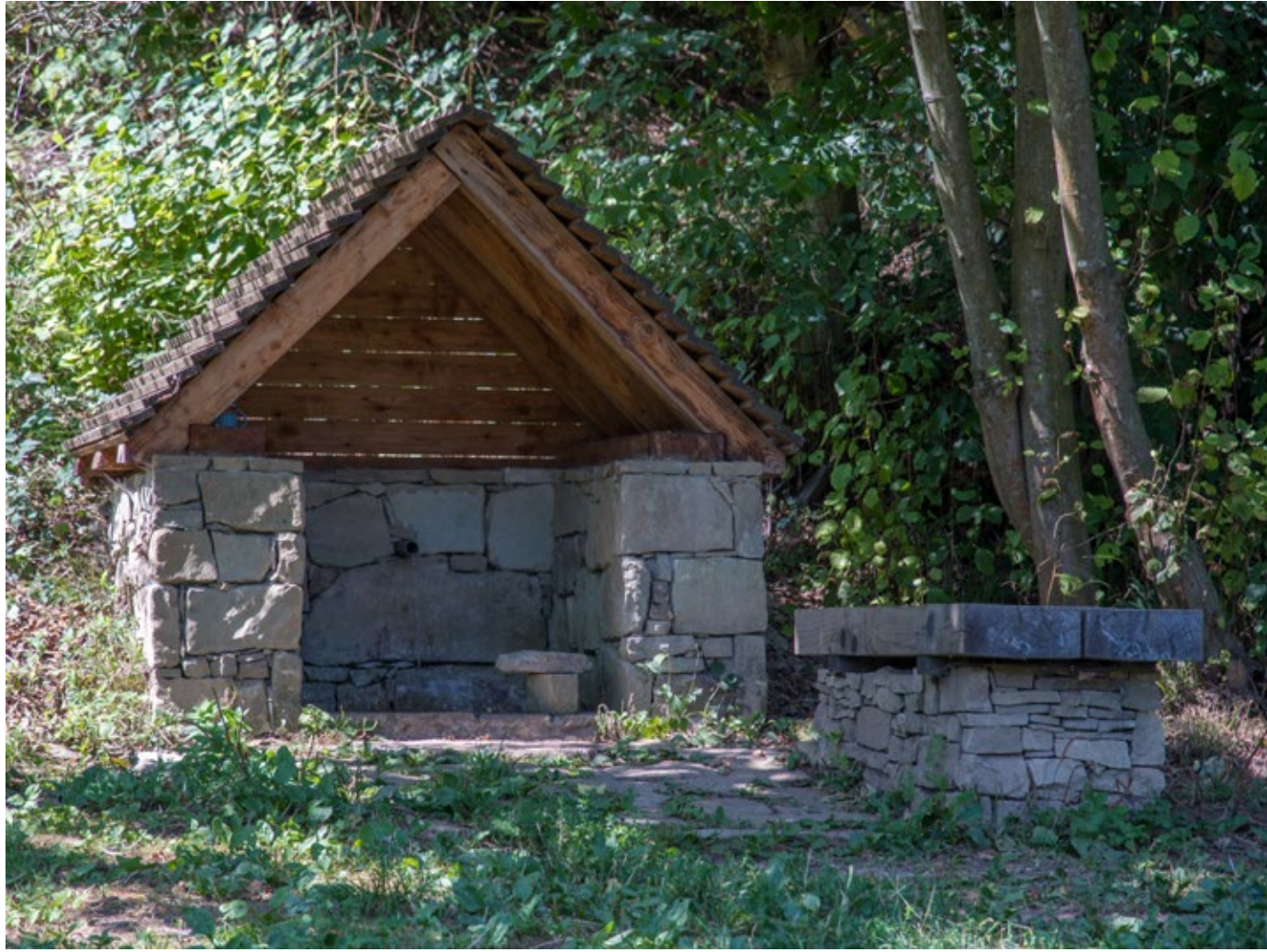
LÁZEŇSKÁ STUDÁNKA obnova. 2017
