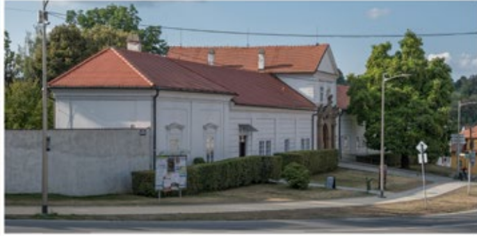
PŘEDZÁMČÍ PŘED ČOKOLÁDOVNOU A PAPIŘNICTVÍM rekonstrukce chodníků. 2018
