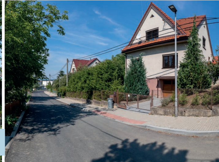
Rekonstrukce místní komunikace na ulici Polní
