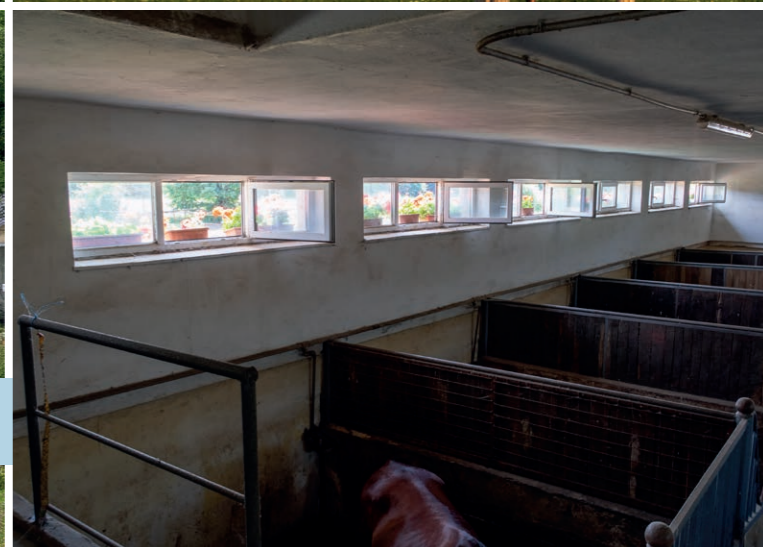
Konírna Vizovice – oprava střechy, vnitřní omítky a výměna oken
